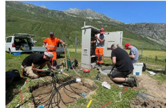
Installation des neuen Bodenmessnetzes in Andermatt, UR. (MeteoSchweiz)
