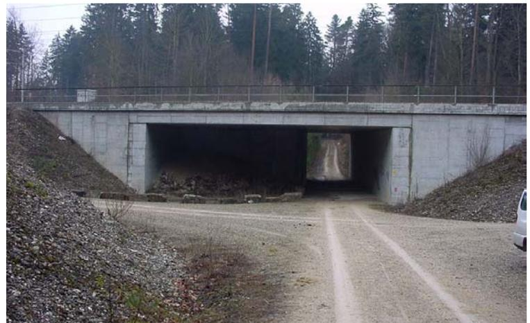
Abb. 12: Unterführung unter SBB-Linie. Der neue Teil ist mit 15 m viel breiter als der alte, die Tiere sehen aber die engste Stelle und meiden die rund 30 m lange und 4,5 m hohe Unterführung.
