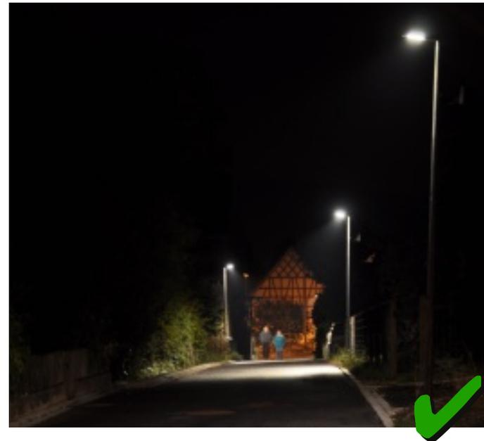
Dank Bewegungsmeldern und LED-Technologie wird die Beleuchtung am Müliweg in Beringen, der neben einem Fledermausquartier liegt, bedarfsgerecht gesteuert. Im Grundzustand sind die Lampen gedimmt, erst wenn sich Passanten oder Fahrzeuge nähern, wird aufgeblendet.
